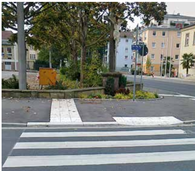
Überquerungsstelle mit differenzierter Bordhöhe an einem Fußgängerüberweg (Zebrastreifen) (Quelle: Wendelin Mühr)
