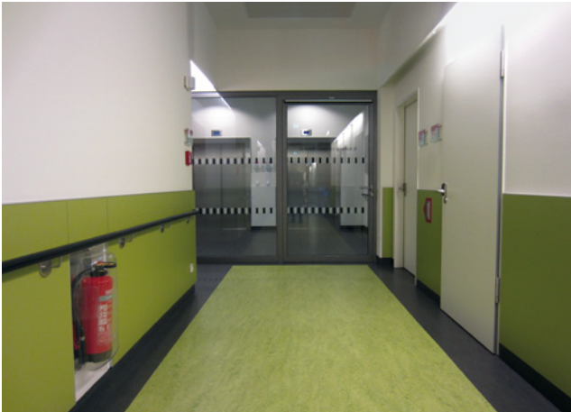
Eingefügter dunkler Randstreifen und dunkle Sockelleiste in einem Flurbereich
